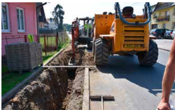
Budowa gminnego wodociągu w Nowej Białej
